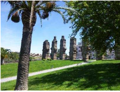
L'aqueduc de Los Milagros
